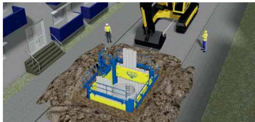
Abb. 20: Schachtverbau (Tiefe gem. Verbausystem), keine fließenden Böden
