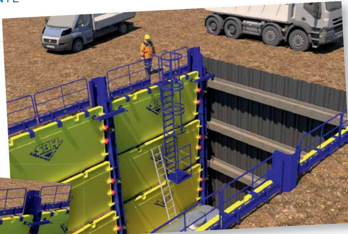
SBH Verbauplattenwand Rammträger
