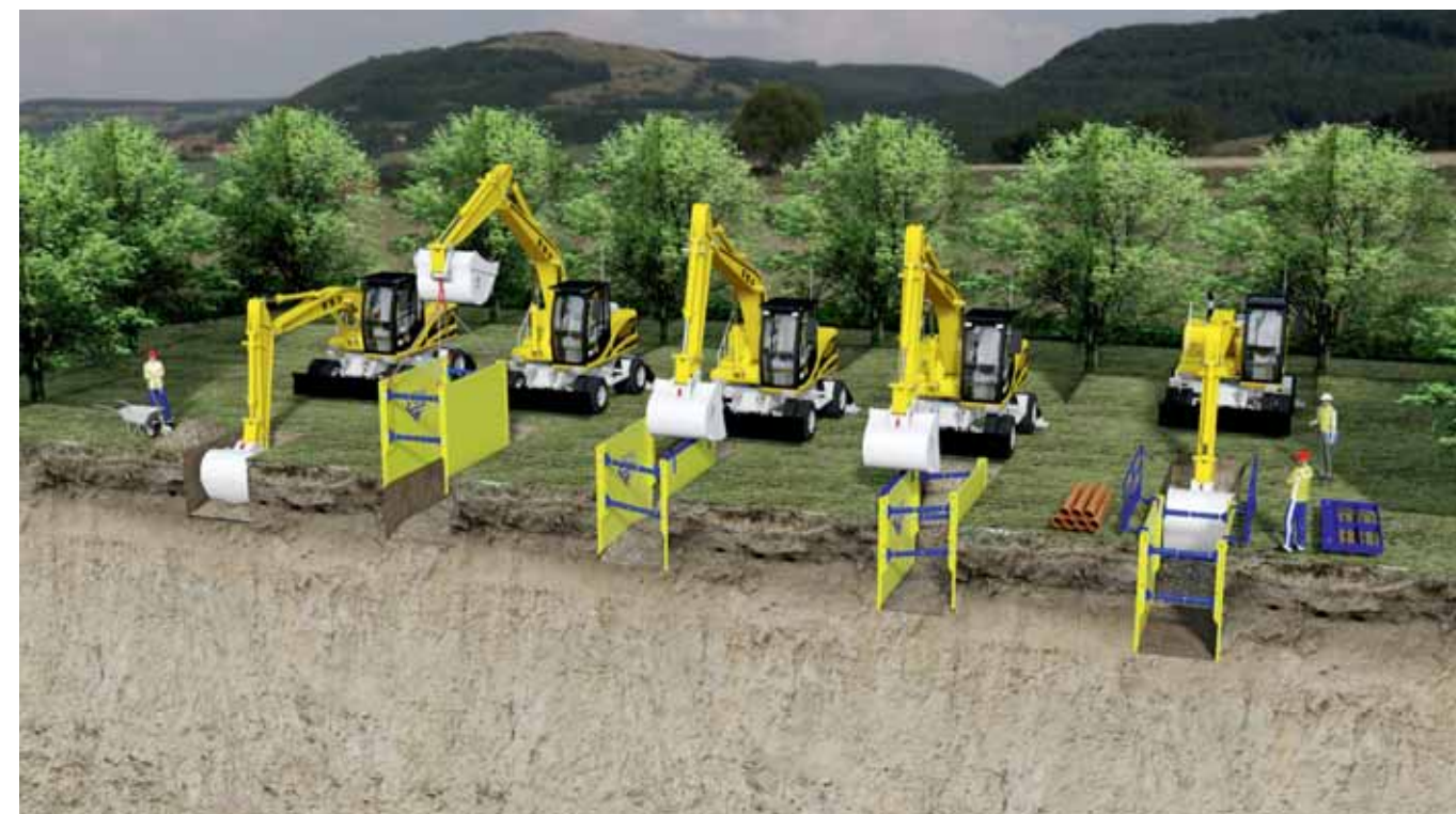
Abb. 28: Absenkverfahren am Beispiel der Standardbox Serie 600
