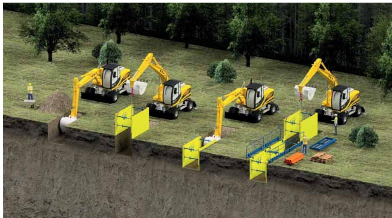
Abb. 27: Einstellverfahren am Beispiel des Leichtverbaus Serie 100
