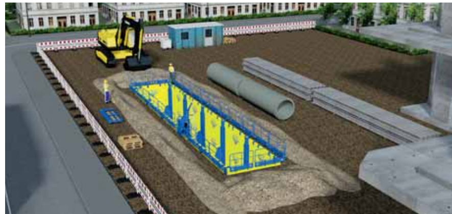
Abb. 19: Absenkverfahren (Tiefe gem. Verbausystem), keine fließenden Böden
