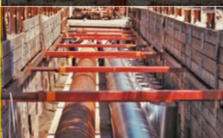
Verbau mit Stahlgurtung
