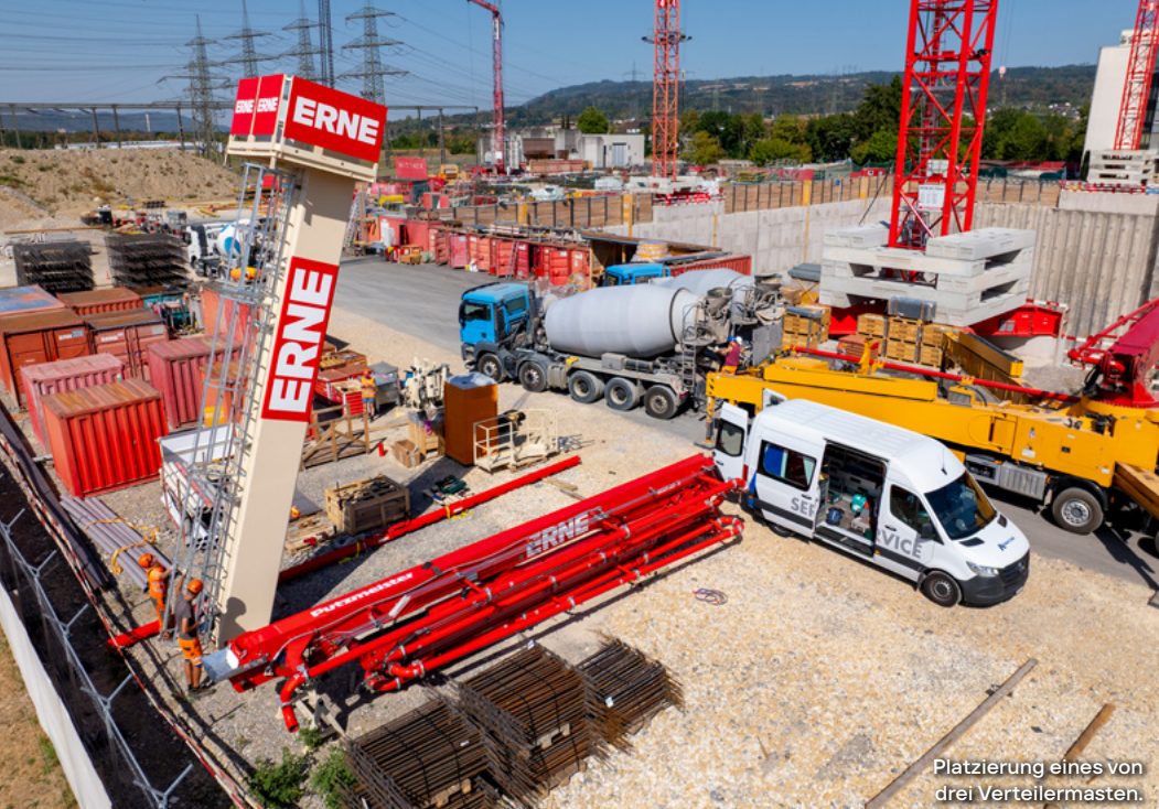
Der 4-armige Verteilermast hat eine Reichweite von fast 35 m.
