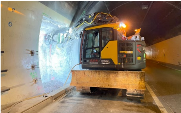
Volvo Kompakt-Tunnelbagger ECR145-T mit 65 kW-Fräse beim Erstellen von Versorgungsnischen in einem Autobahntunnel
