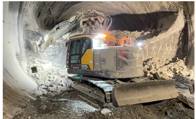
Volvo Kompakt-Tunnelbagger ECR355-T mit Reißlöfel beim Grabvortrieb von einem doppelgleisigen S-Bahntunnel
